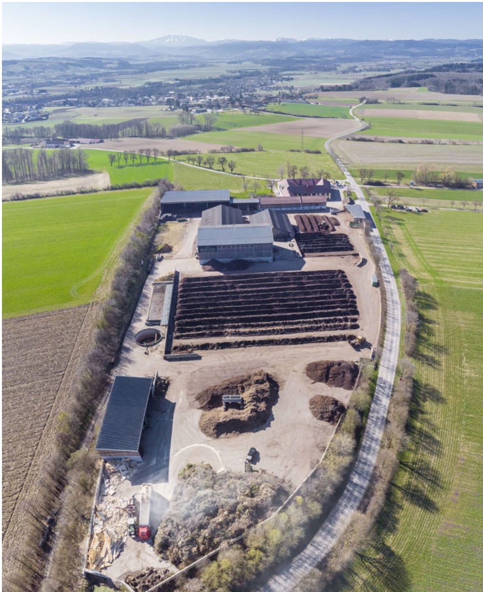
Seiringer Kompostanlage Foto: Seiringer US GmbH
